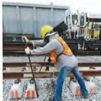
รูปแสดงการวัดระยะหมอนและติดตั้งแผ่นป้องกันสะเก็ดไฟ
