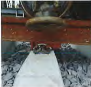
รูปแสดงการติดตั้ง Rail Taper Block
